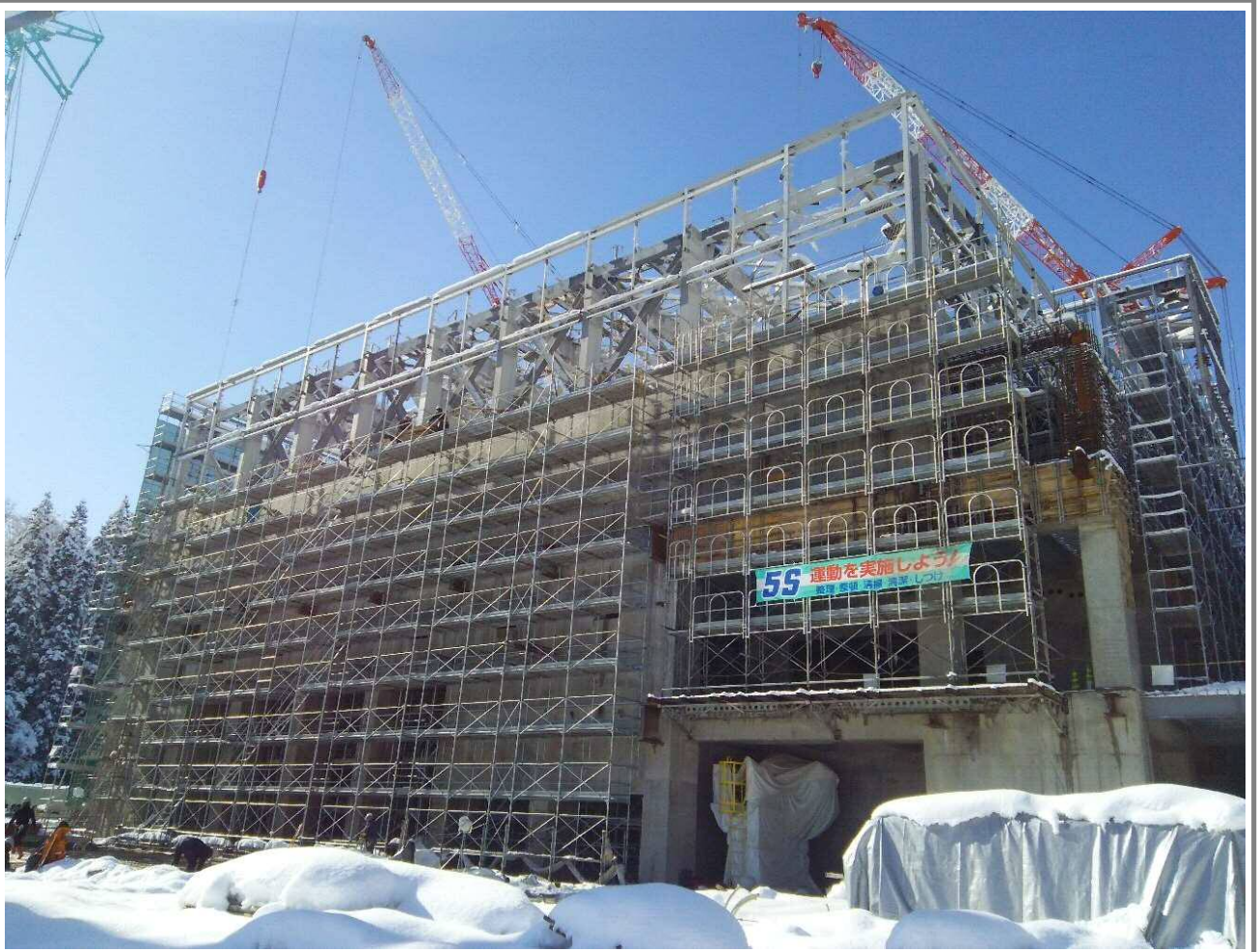
建設現場のようす【1月12日撮影】
